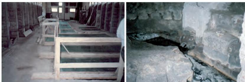
Fig.6-Le antiche opere di captazione: Internodel padiglione soprastante la vecchia galleria e la vasca di raccolta con il canale di deflusso delle acque mineralizzate
