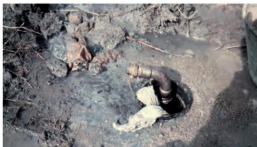
Fig. 12 - Impianto di eduazione dell'acqua mineralizzata nella perforazione N. 2
