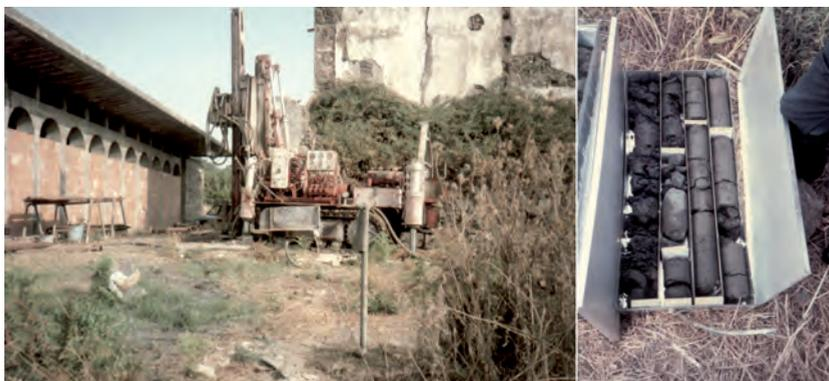
Fig. 8 - Perforazione geognostica e relativo carotaggio
